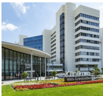
Sicherheitsmaßnahme im Klinikum Wels bleibt. Foto: Klinikum Wels-Grieskirchen
