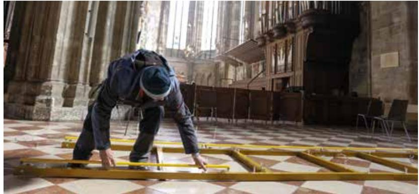
Die Leiter konnte nur in Teilen hinaufgeseilt werden und musste anschließend zusammengesetzt und verkabelt werden
