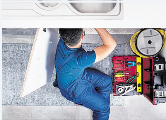
Gewerke wie Elektriker und Installateure bekommen derzeit fast nur Auftragsstornos
